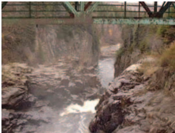
Figure 21 Chute près de la route 138 : barrière infranchissable pour le saumon atlantique sur la rivière aux Anglais (Source : Fédération québécoise pour le saumon atlantique)
